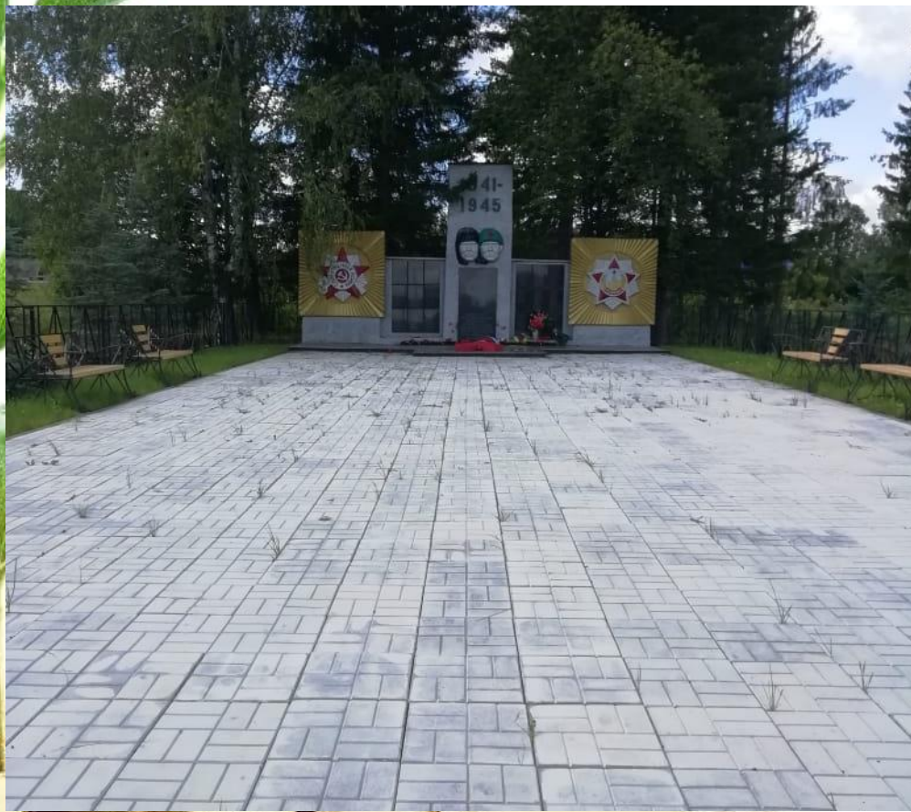
Территория памятника ПОСЛЕ благоустройства (выполнена укладка тротуарной плитки и установка бортовых камней, установлено металлическое ограждение, приобретены кованые диваны)
